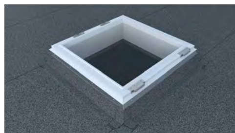
4 Aufsetzkranz eindichten Sealing the upstand
