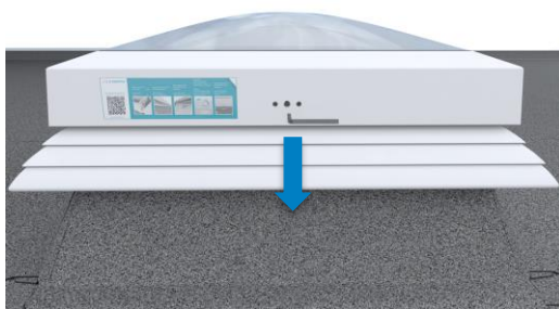
15 Vierkant herausziehen Pull out the square shaft
