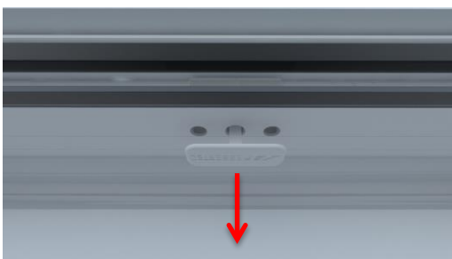
26 Abdeckklappe herausnehmen Remove cover cap
