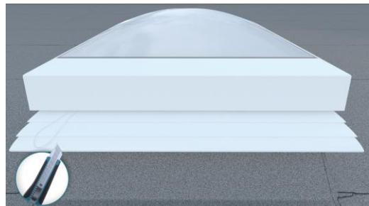
18 Zugschnur abschneiden Cut off pullcord
