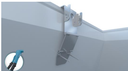
7 Grundplatte festnieten Fix base plate with rivets
